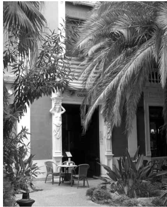
Casino Balneario Vista del patio y entrada del antiguo Casino del Balneario de Archena, recién rehabilitados, con mucho acierto, como lugar de esparcimiento.
