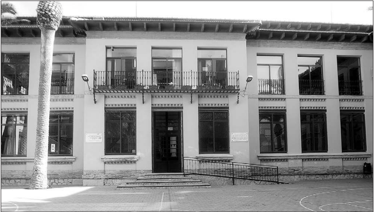
Fachada principal del colegio.
