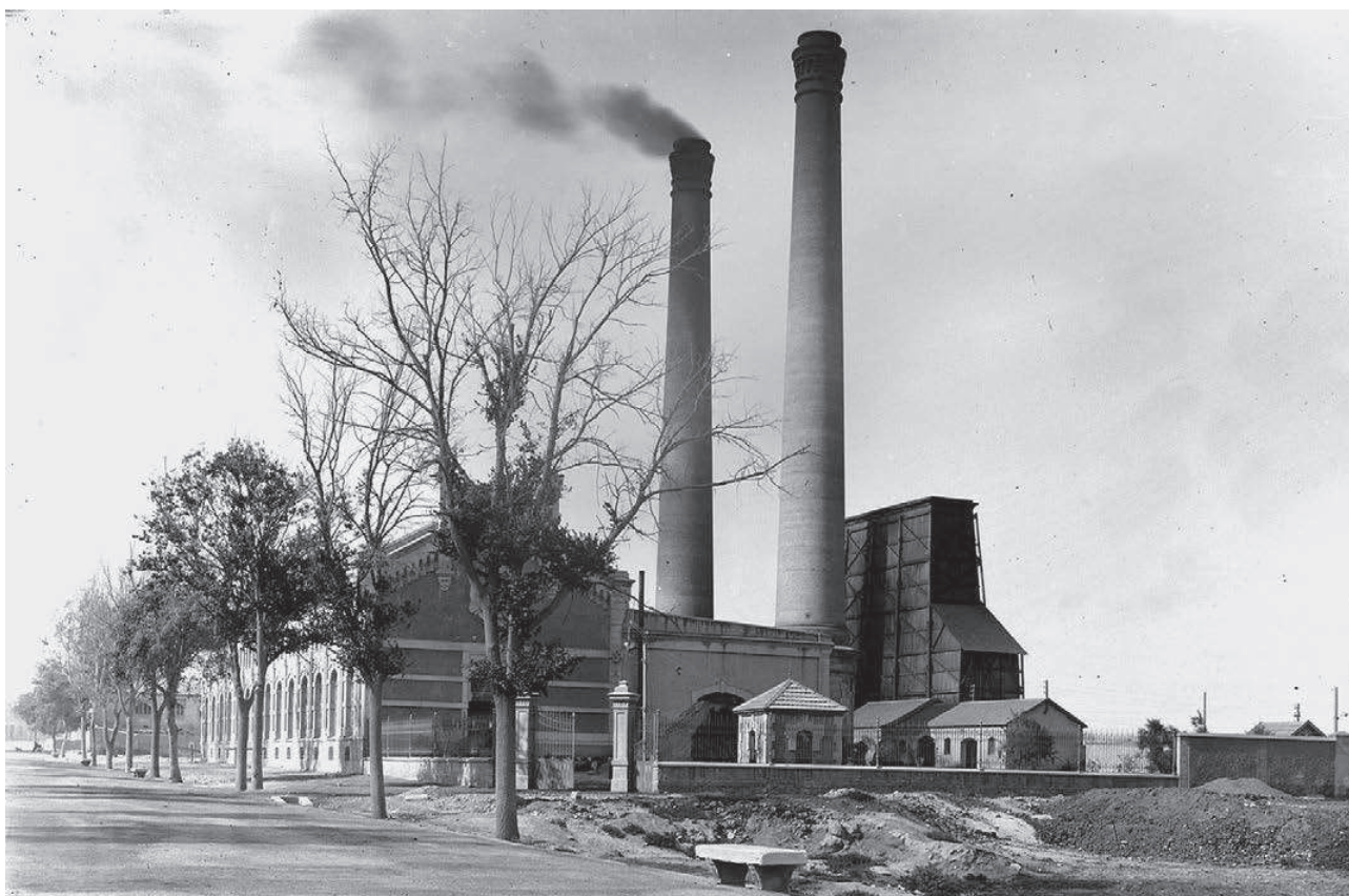
Fábrica de Fluido Eléctrico Hispania (Central Eléctrica Ahlemeyer) en Cartagena, c. 1915, Archivo General Región de Murcia (AGRM), Fot_Neg.002/04
