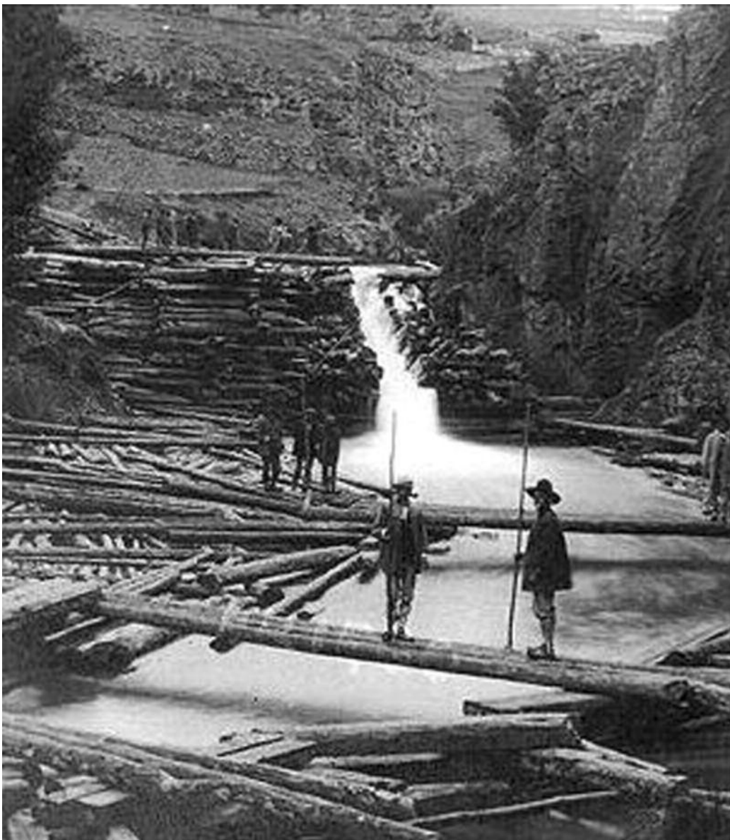
Conducción de maderas
