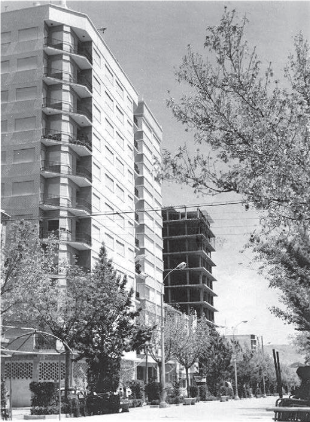
Edificio que ocupa el solar del antiguo Teatro Borrás
