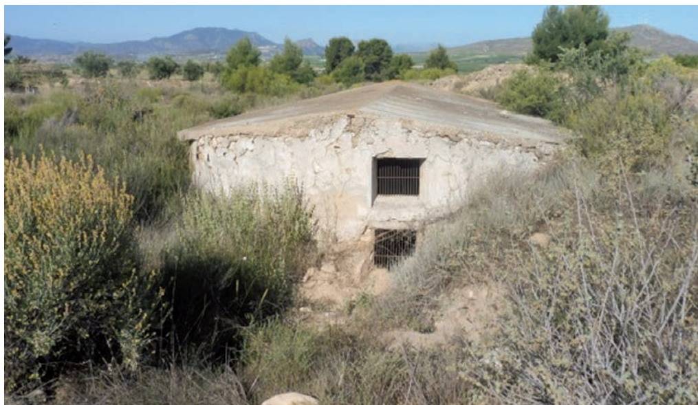
Foto 4: Aljibe de Agapito (vista posterior). Foto del autor
